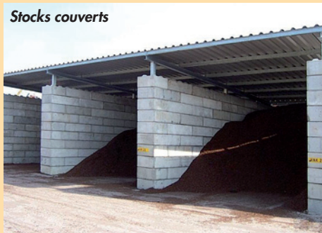
Mur de soutènement
